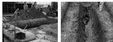
腐食等劣化による事故の例
